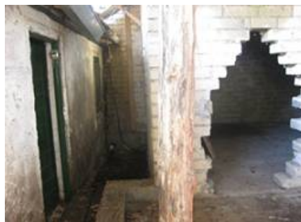
Entrata abitazione (sin.) e rustico (dx)
